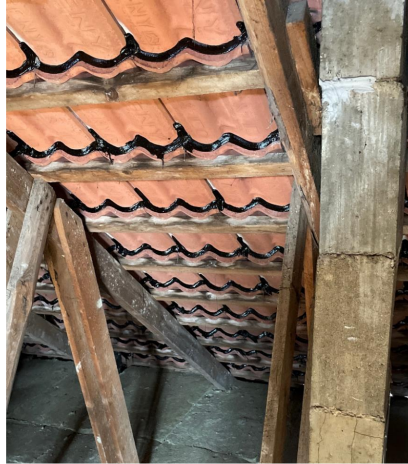
Betontagsten med bitumen understrygning blok 14 og 16.
