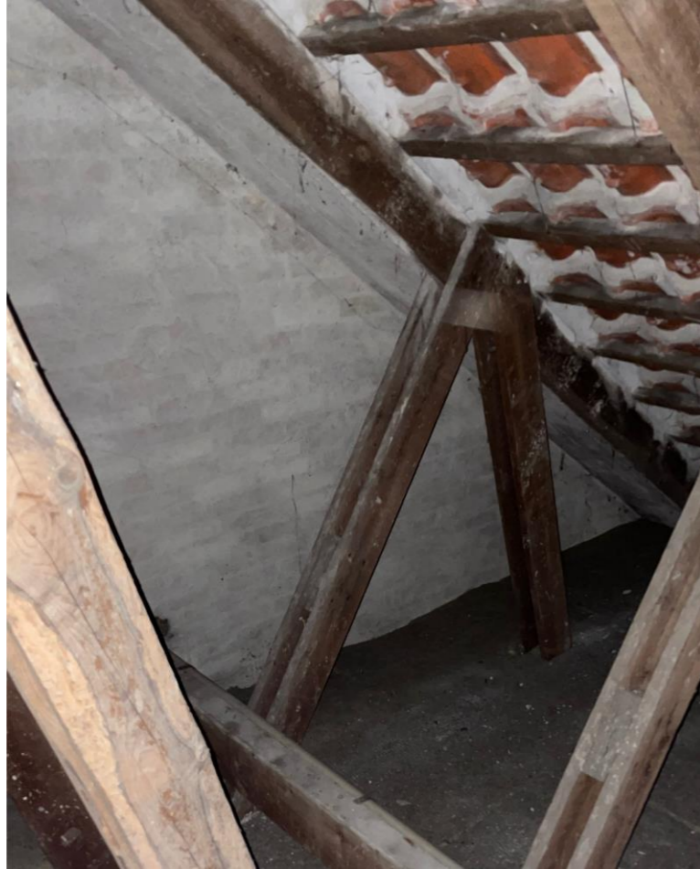
Gammel dansk tegltagsten med mørtel understrygning blok 12.
