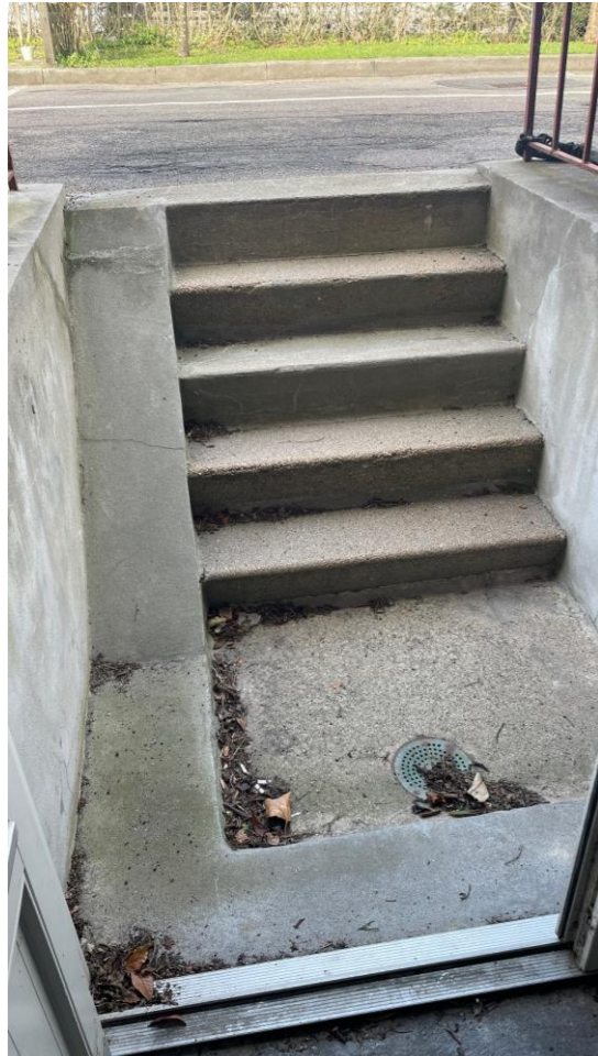
Alle eksisterende kældertrappe nedrives
