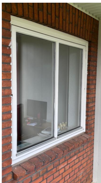
Eksisterende træ vindue mod lukket altan.
