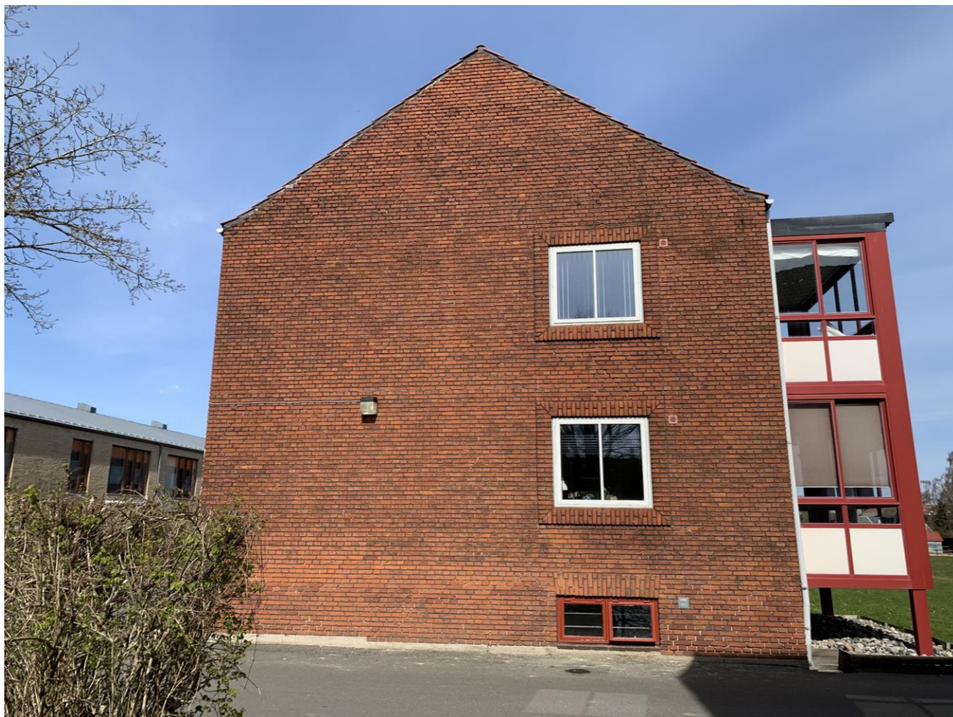
Eksisterende gavle nedrives.
