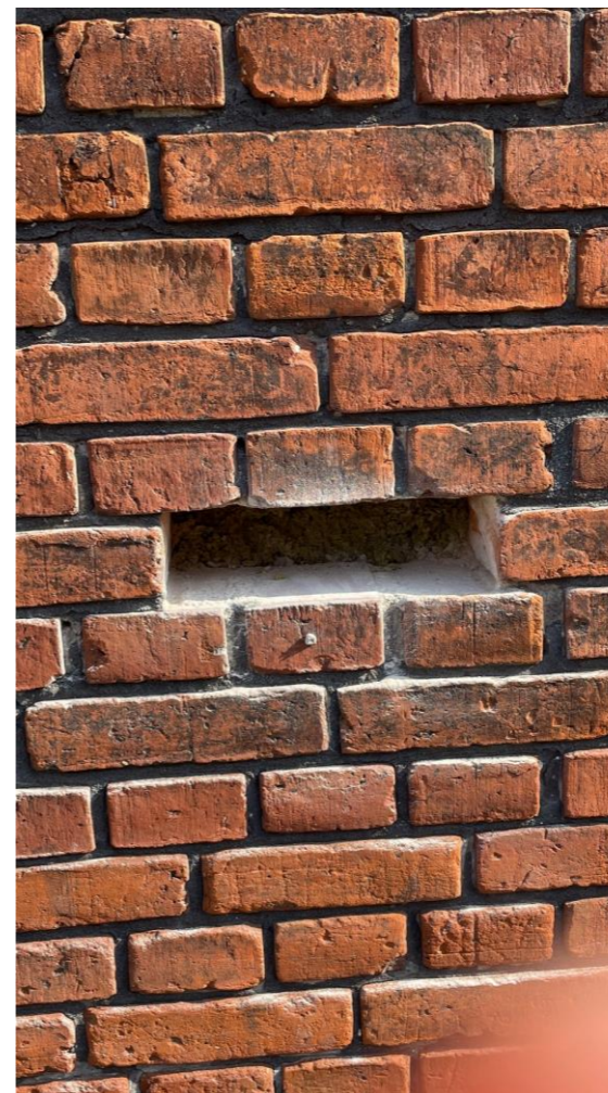
Udskiftning af skadede mursten.
